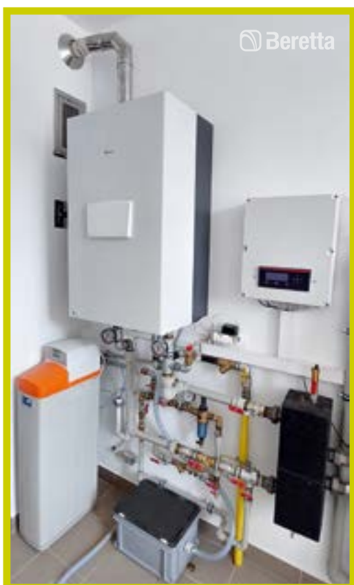
◀◀ POWER MAX 65P Żłobek przy SP nr 2 w Skrzyszowie
